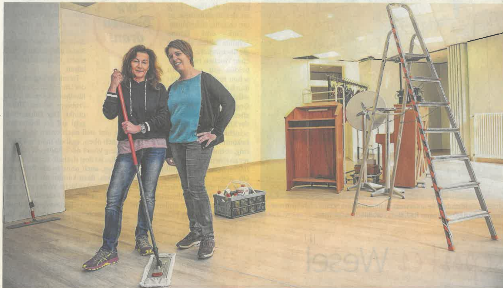
Renovierungsarbeiten im Mehrgenerationenhaus (MGH) in Wesel: Ute Zuckermann, Leitung Koordination MGH Bogen (l.) und Ilka Mainka, Projektkoordinatorin MGH, packen mit an.
